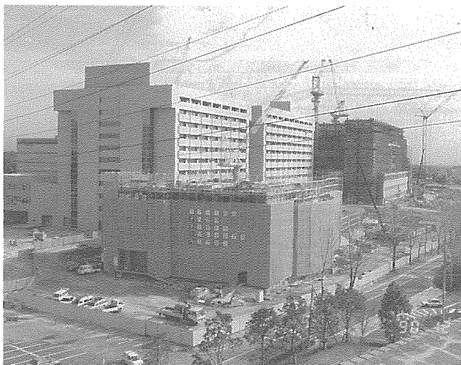
写真：建築進む「生命科学図書館」 (手前が生命科学図書館、後方の建物は医学部)
