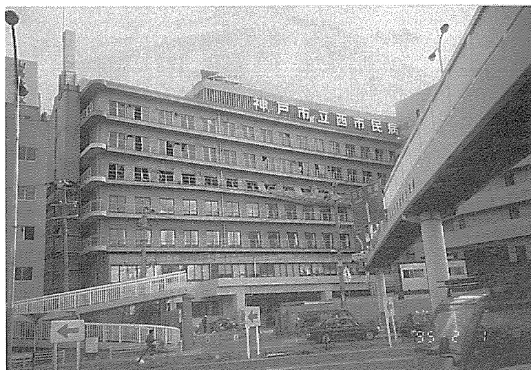
写真1 崩壊した公共建築（神戸市立西市民病院）
