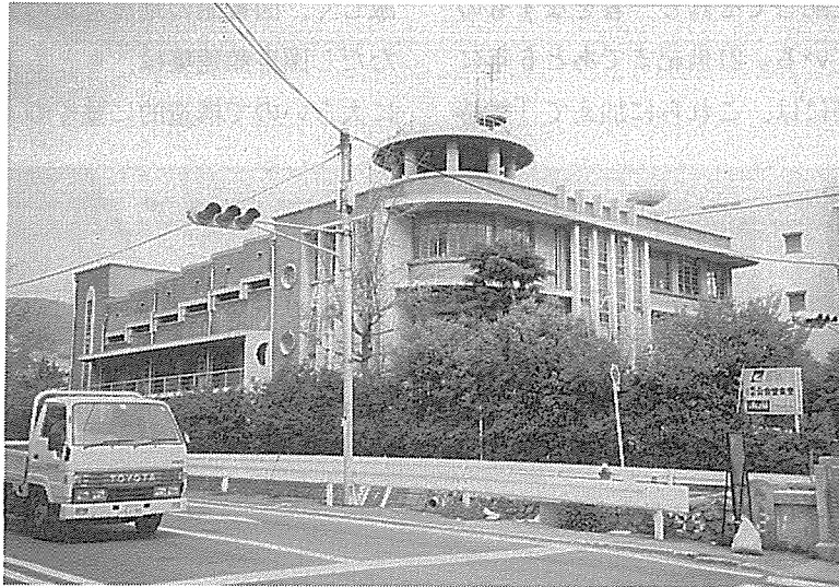
写真2 地震に耐えた戦前の公共建築（御影公会堂）
