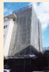
外壁の工事中（総合図書館）
